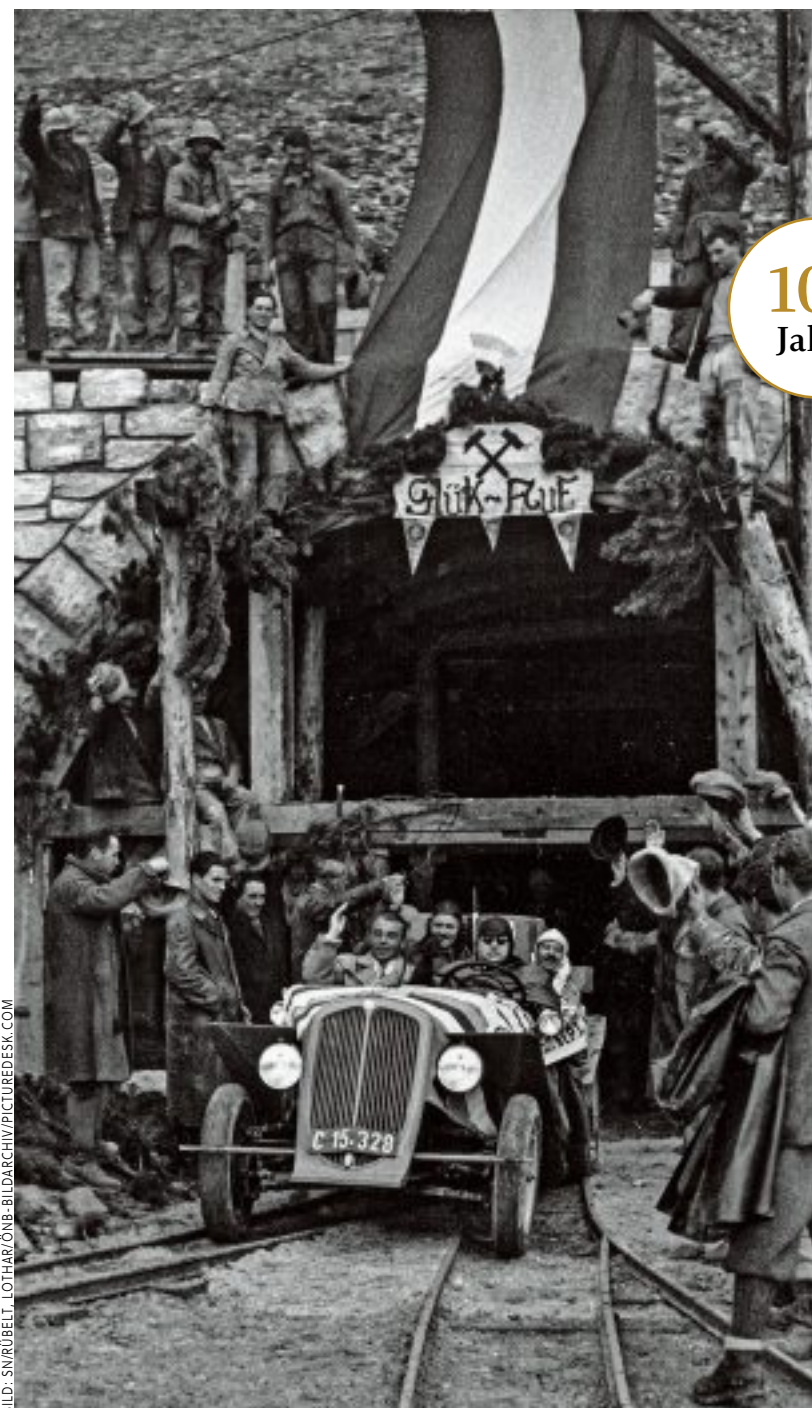
Franz Rehrl am Steuer eines umgebauten Steyr 100 und Glocknerstraßen-Erbauer Franz Wallack bei der ersten automobilen Überquerung der Hohen Tauern 1934 über die im Rohbau befindliche Großglockner-Hochalpenstraße.
