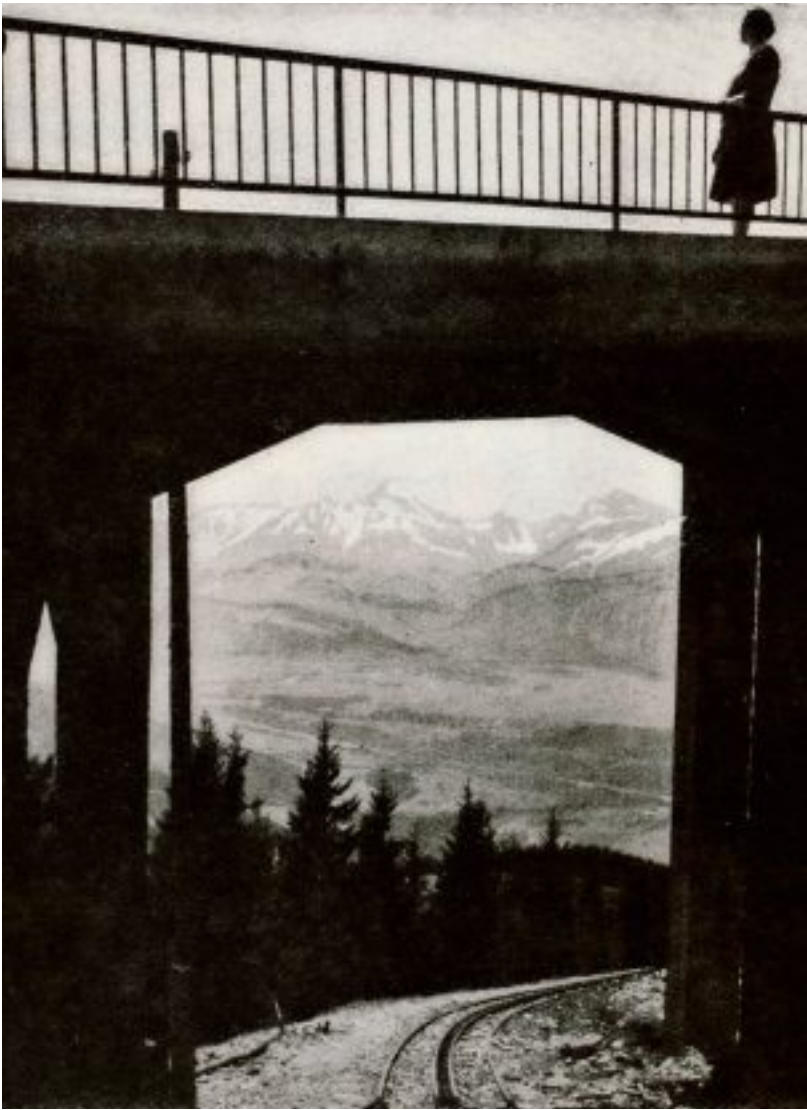
Neue Aussichten für den Fremdenverkehr versprach auch die Panoramastraße, die 1929 die Bahn auf den Gaisberg ablöste.
