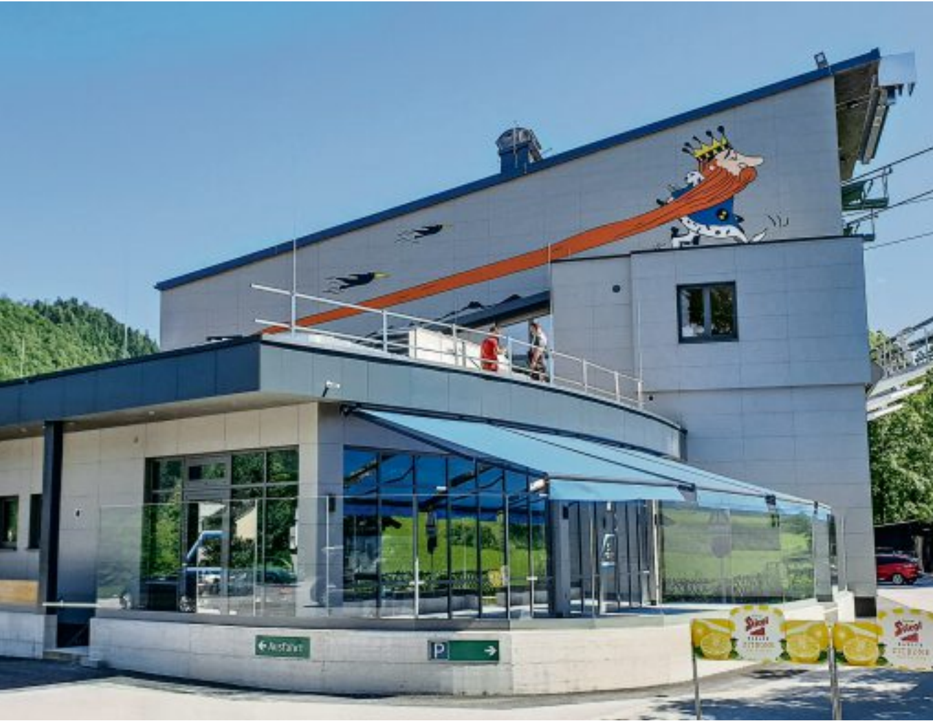
60 Jahre nach der Eröffnung wurde die Talstation der Untersbergbahn einer Komplettsanierung unterzogen.
